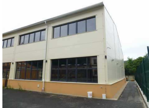
Hala - administrativní část a sociální zázemí
