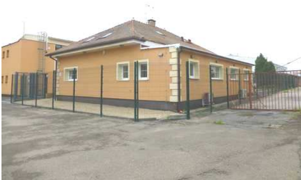
Administrativní budova - pravá a zadní strana
